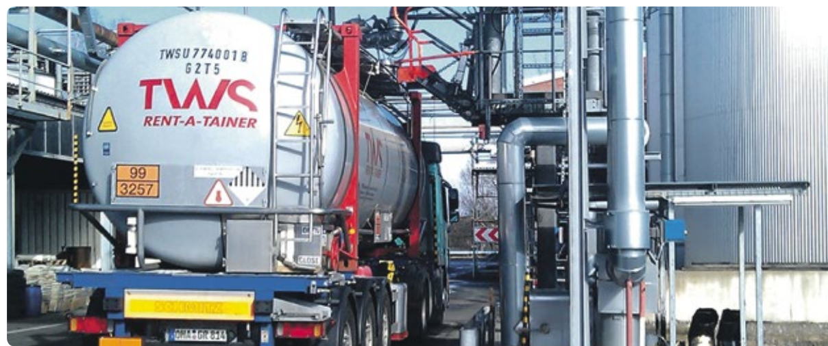
Container wird mit Bitumen beladen.
