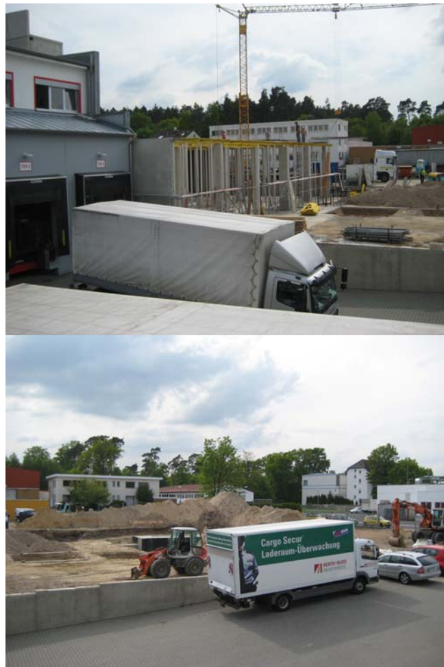
Abbildung 3: Blick auf die Baustelle des neuen Wareneingangsgebäudes Quelle: TIM CONSULT GmbH
